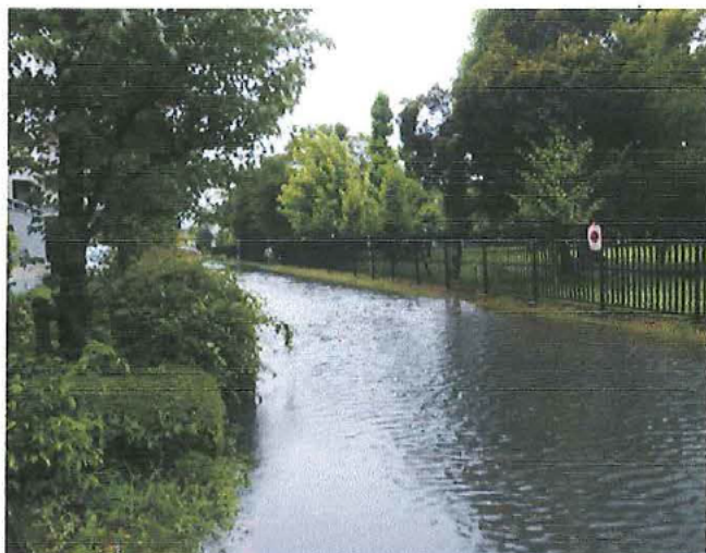
2016年8月22日（月）午後1時50分ころ 五領町近隣公園とパークタウン五領第六団地 の間の道路が完全に冠水している状態 （4号棟付近から撮影）
