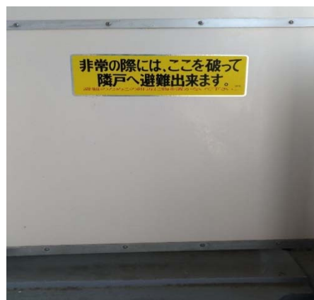
写真2 ベランダ間仕切板
