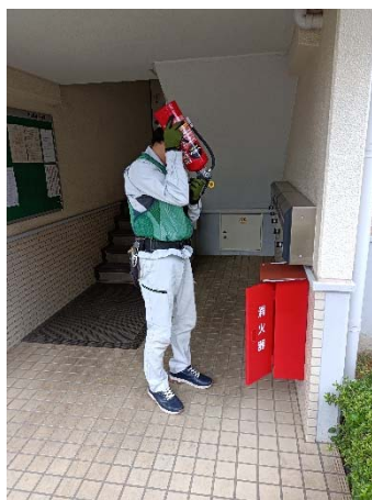
消火器点検(77ヶ所)
